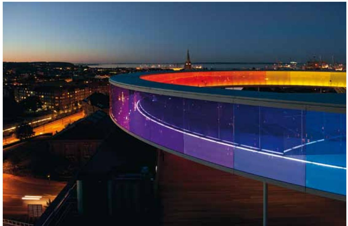
B2 | Spezielle in den Boden eingelassene Sonderleuchten lassen die einmalige Installation – wie einen echten Regenbogen – in den Spektralfarben erstrahlen. Dazu wird die Decke symmetrisch ausgeleuchtet, so dass die bunten Glasscheiben von innen heraus farbig leuchten.
