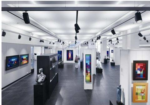
**Bild 1:** Für die Inszenierung der Kunstwerke im Ton Schulten Museum wurden insgesamt 230 Strahler an Supersystem Schienen montiert.
