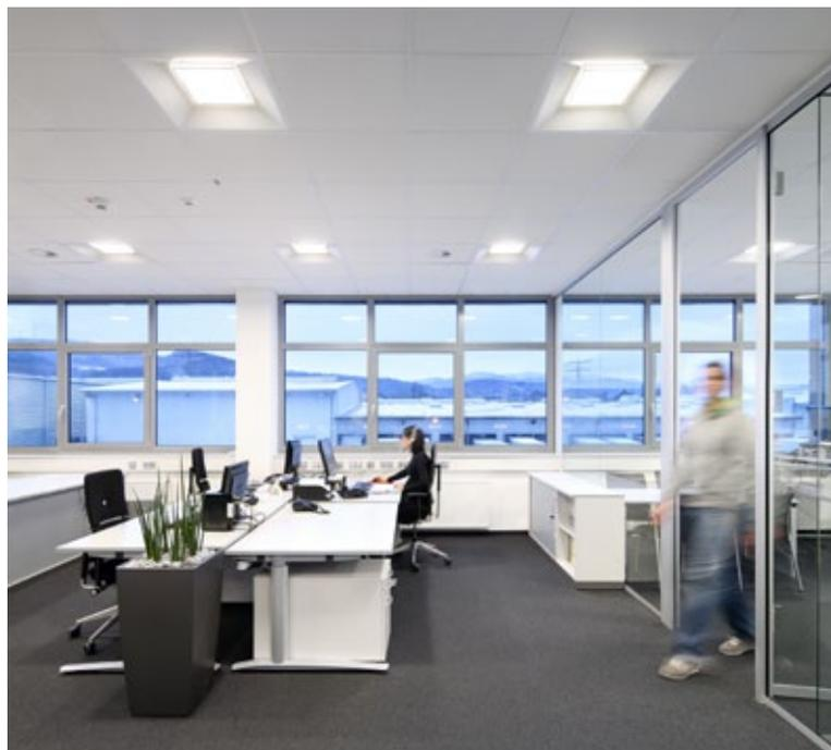
B2 | Die zum Großteil auf LED basierende Lichtlösung setzt Maßstäbe für eine energieeffiziente und qualitativ hochwertige Arbeitsplatzbeleuchtung. Als Sonderlösung wurde das LED-Downlight Crayon deckenbündig eingebaut und garantiert damit eine flexible Raumnutzung.
