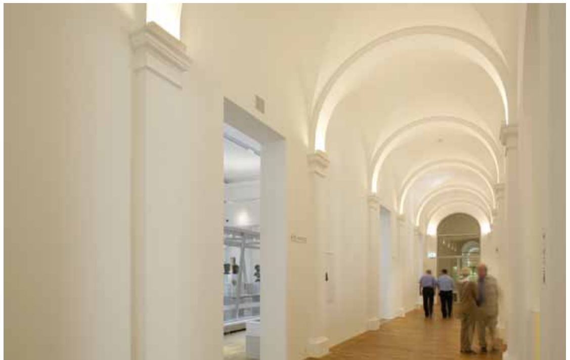
B2 | Zurückhaltend integrierte Sonderleuchten sorgen in den Fluren für eine ansprechende, indirekte Deckenbeleuchtung.
