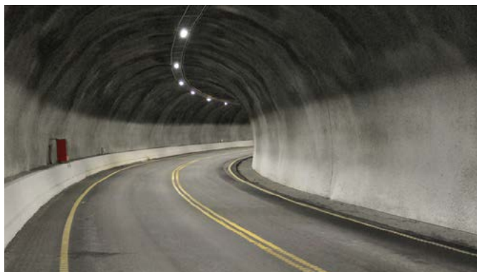
GTLED senkt den Energieverbrauch in den Tinnsjotunnels um 40%.
