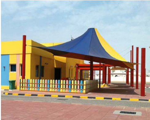
Auch diese Schule ist Teil des Abu Dhabi Future School Programmes.
