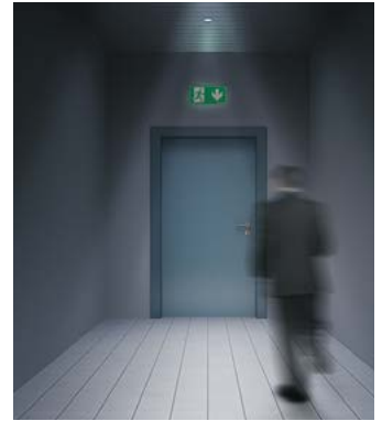
Ausleuchtung mit einer Leuchtdichte des Piktogramms von 2 \text{ cd/m}^2
