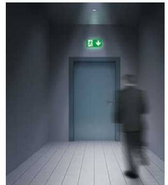
Ausleuchtung mit einer Leuchtdichte des Piktogramms von 200 \text{ cd/m}^2
